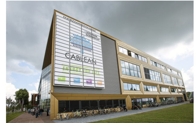
figuur 28-Duurzaamheidsfabriek-bron Duurzaamheidsfabriek
